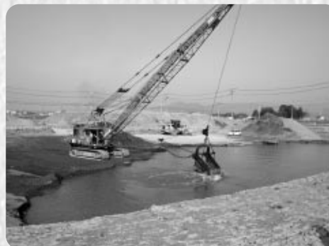
砂利を掘削する現場
